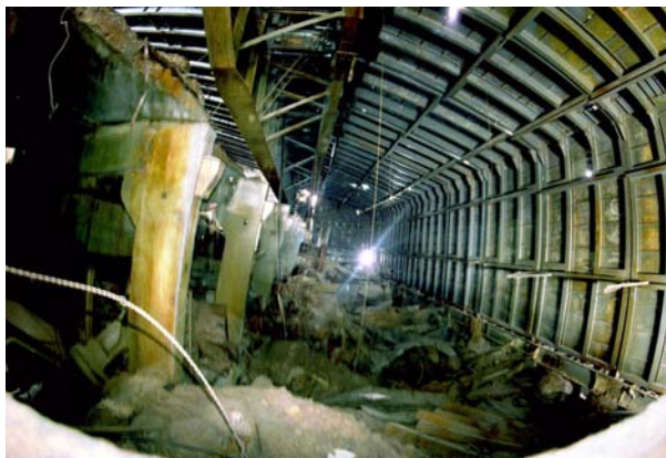
РИС. 7.3. Реакторный зал блока 4 после аварии.
